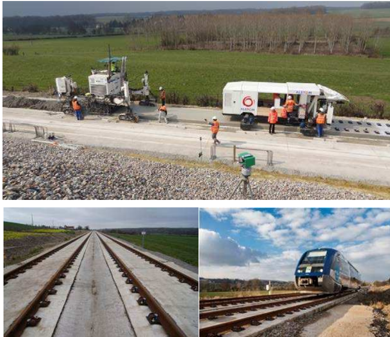
Figure 3. Voie expérimentale NBT. Photo du haut : la machine à coffrage glissant (à gauche sur la photo) et la machine Appitrack d'insertion des selles (à droite sur la photo). Photos du bas : la voie NBT en service
